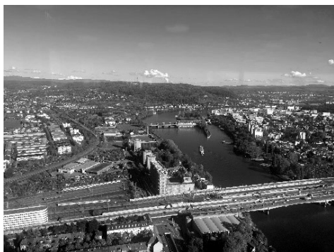
Blick über das Kraftwerk Birsfelden. Im Hintergrund der Fernsehturm St. Christoph. Leider nur schwach zu sehen.
